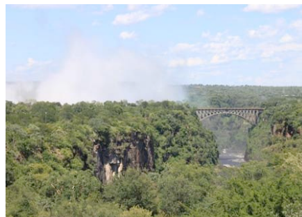
Blick auf die Brücke
