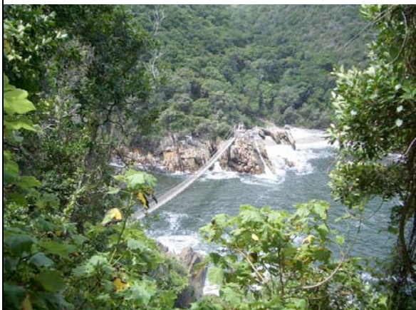
Hängebrücke über den Storms River
