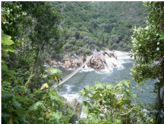
Hängebrücke über den Storms River
